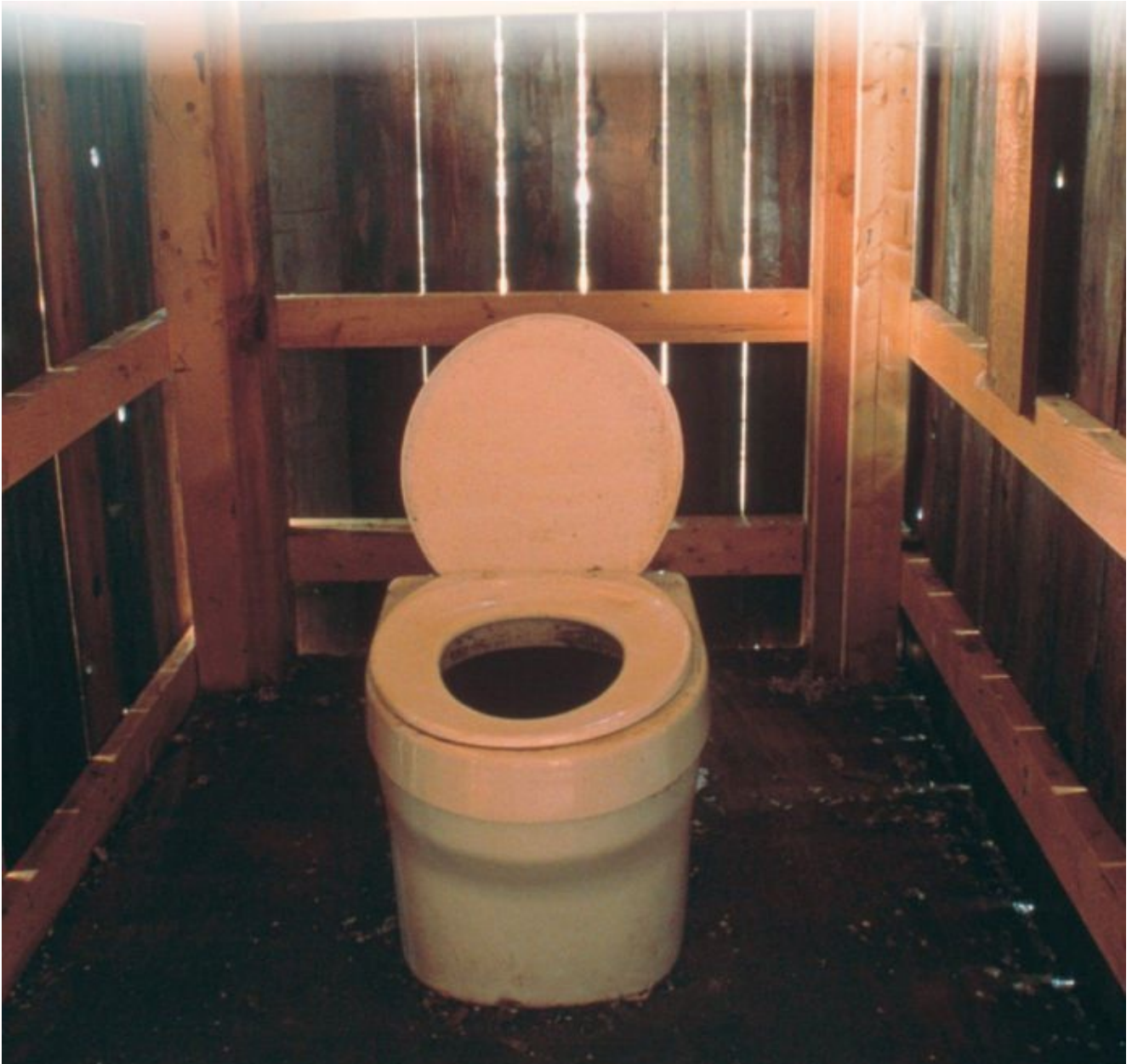
Một nhà vệ sinh ủ phân hoạt động không cần nước hay hệ thống cống.
