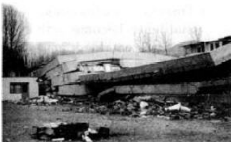
Earthquake - Động đất
