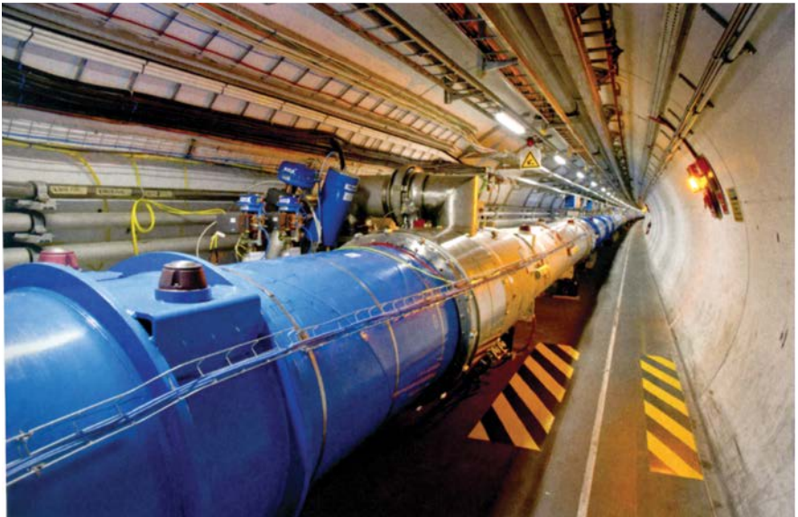
20. Trong LHC, hai chùm hạt, mỗi chùm chứa hàng trăm tỷ proton, được gia tốc tới vận tốc gần bằng tốc độ ánh sáng và được dẫn hướng bằng hàng nghìn nam châm, đi theo chiều ngược nhau, và đập vào nhau với một năng lượng tương đương với năng lượng của vũ trụ tại một phần nghìn tỷ giây sau big bang.
